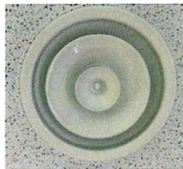
Figura 1 – Batteria a soffitto
